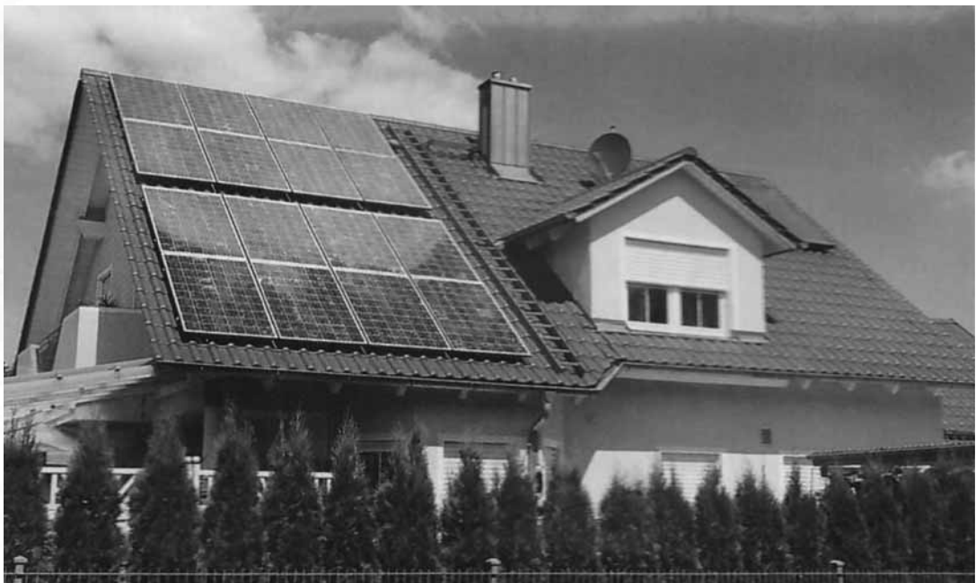
Фото 1. Расположение солнечной электростанции мощностью 5 кВт
